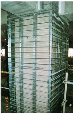
鋼管柱表面裝修輕鋼架
