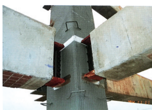
吊裝完成之半預鑄樑
